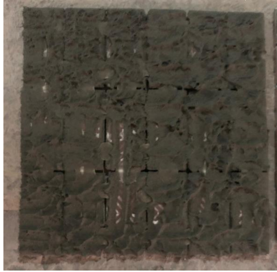
Figura 2 – PREENCHIMENTO ADEQUADO DO VERSO (TARDOZ) DO REVESTIMENTO. Cordões de argamassa foram esmagados e o tardez está com mais que 90% preenchido com argamassa colante.
