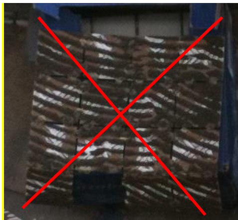
Figura 1 – PREENCHIMENTO INADEQUADO DO VERSO (TARDOZ) DO REVESTIMENTO. Não deve ser observado o desenho dos cordões.
