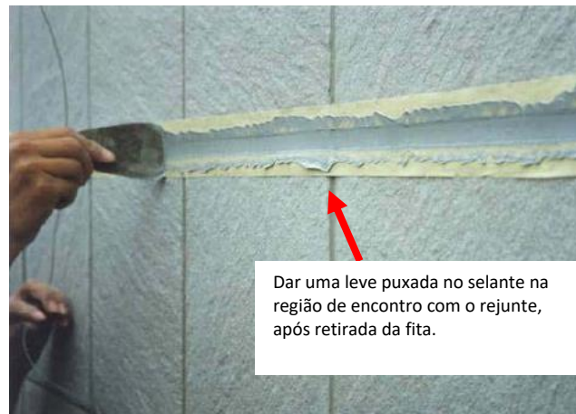
Figura 5 – Frisamento da junta com espátula metálica ou plástica. Na região com revestimento dar uma leve puxada no selante, em cada encontro com o rejunte.
